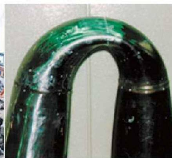
災害に強い中圧ガス
