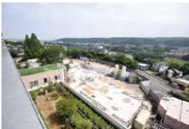
(解体後・2020年7月)
