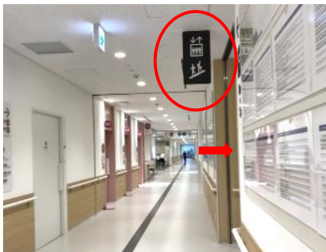
1F: エレベーター入口
