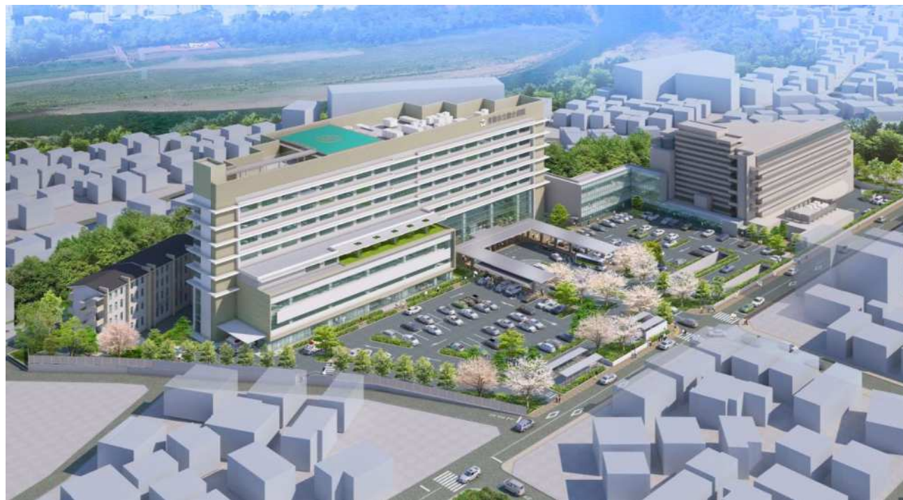
正面駐車場側より
